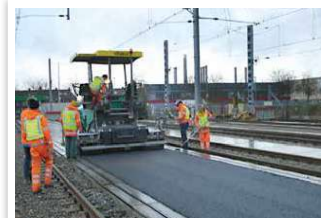
POSE D'ENROBÉ SUR LES QUAIS DE GARE
