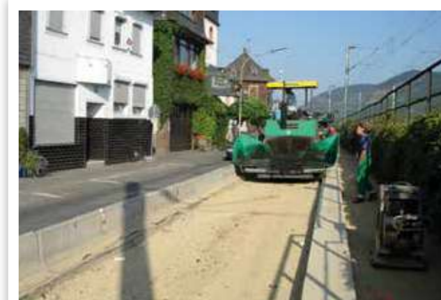
RÉFECTION DE VOIES URBAINES
