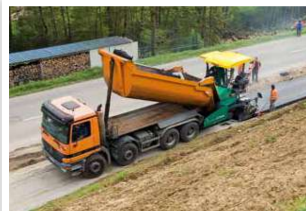
POSE D'ENROBÉ SUR TROTTOIRS / PISTES CYCLABLES COMBINÉS
