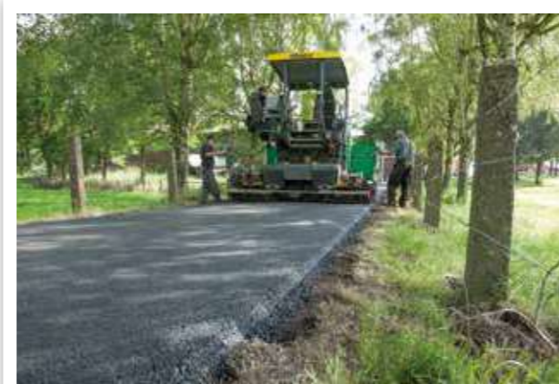
RÉFECTION DE VOIES D'ACCÈS
