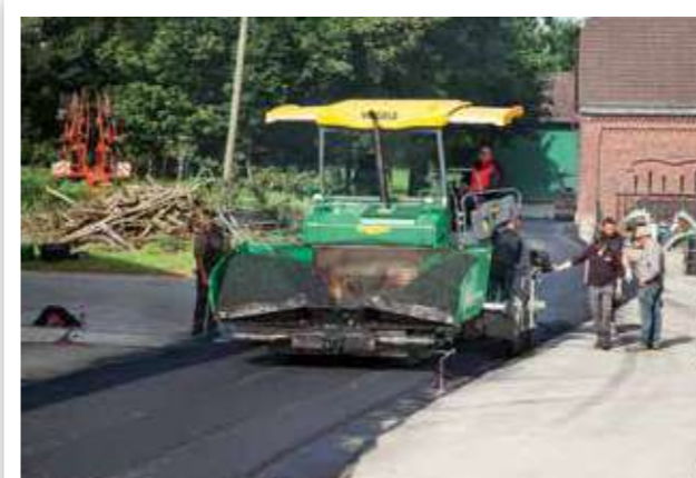
POSE D'ENROBÉ EN ZONES INDUSTRIELLES ET COMMERCIALES
