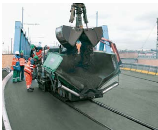
Pose d'enrobé entre des rails de tramway
