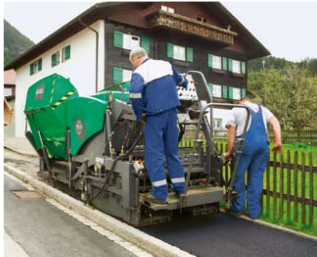
Réfection d'allées piétonnes et de pistes cyclables
