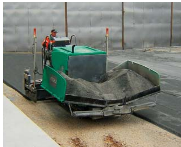
Construction de places
