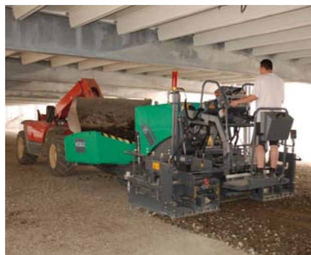
Mission à l'intérieur de bâtiments
