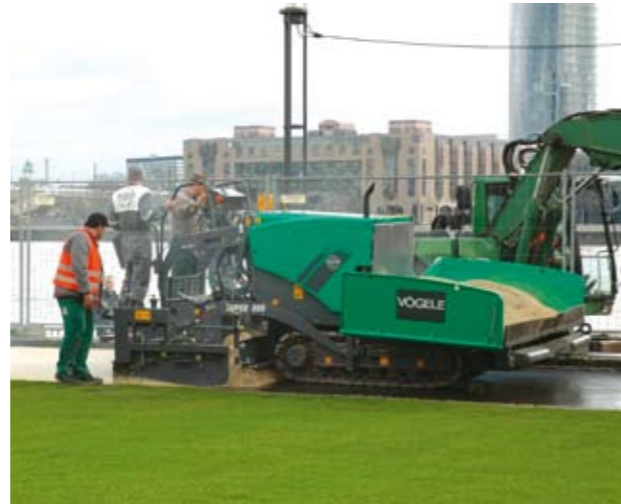
Construction de chemin dans des parcs, etc.
